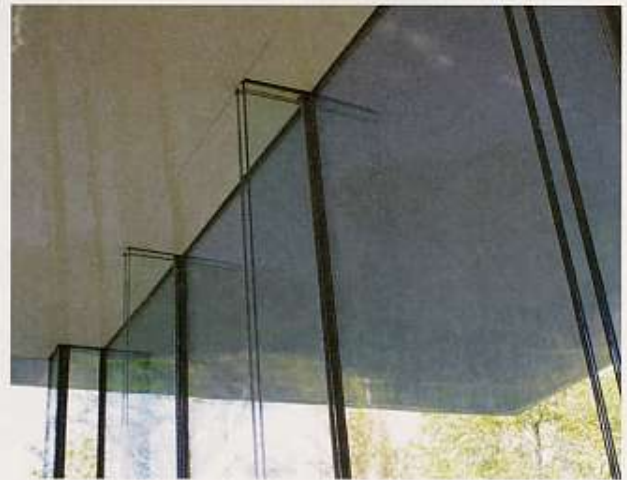
Glasschwerer: Sie bilden mit dem Fassadenglas U-Träger und übernehmen so die Aussteifung der Fassade.
