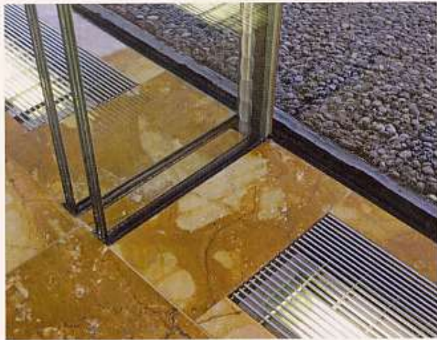
Fester Halt: Unten sind die Glaselemente in ein Stahlteil eingebunden, das selbst wiederum im Gebäude verankert ist.
