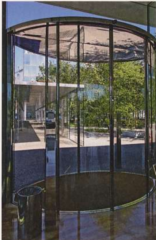
Herausforderung: Die Glasflächen über den Türen – links die Rundschiebetür – leiten ebenfalls Lasten ab. Wie auf dem Grundriss dargestellt, befindet sich eine zweiflügelige Tür gegenüber.
