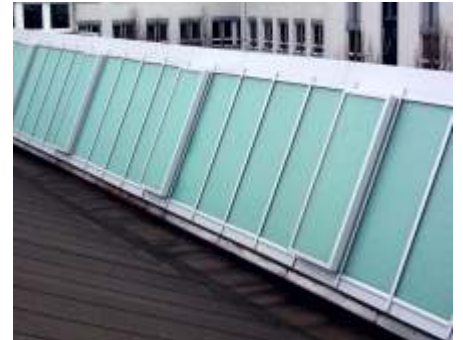
Sanierung Sheddach Siemens München
